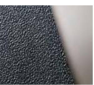
revestimiento de la estructura de protección
